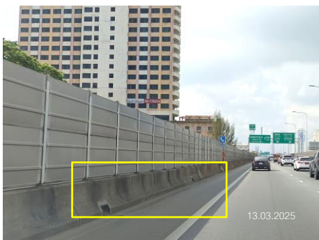
ภาพที่ 2-1 ตะแกรงรับน้ำตลอดแนวเส้นโครงการ บริเวณเหนือคลองประปา
